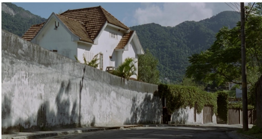
Figura 2 – Vista geral da casa de O que é isso, companheiro?
