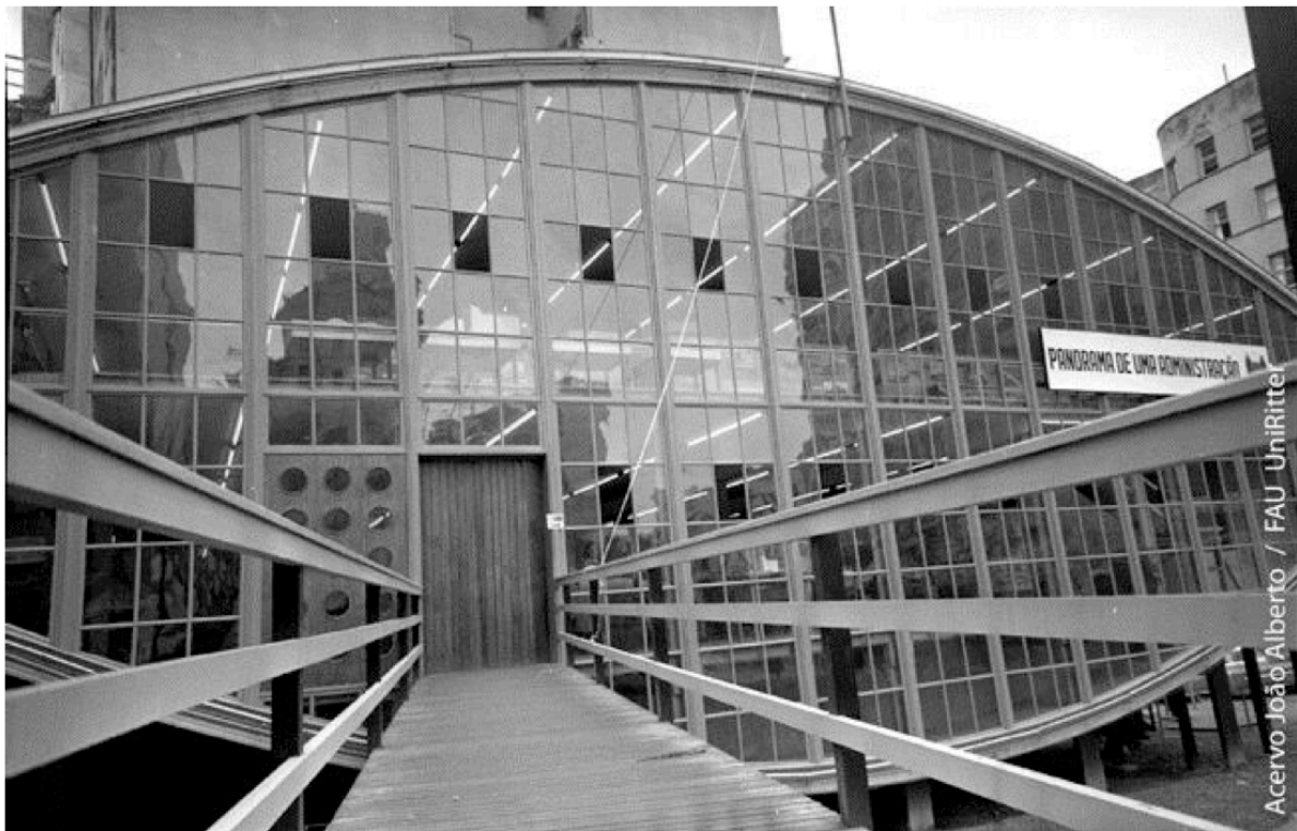
Figura 11: Vista diurna do Pavilhão de Exposições do Governo do Estado do Rio Grande do Sul (“Mata-Borrão”). Arquiteto Marcos David Heckman, 1960. Fotógrafo: Joao Alberto Fonseca da Silva. Fonte: Laboratório de História e Teoria da Arquitetura do UniRitter.
