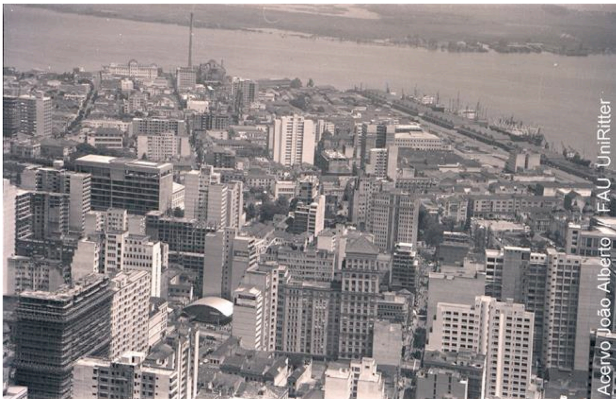
Figura 10: Tomada aérea da área central de Porto Alegre, na qual se vêem o Pavilhão de Exposições do Governo do Estado do Rio Grande do Sul (“Mata-Borrão”) e os edifícios do Palácio da Justiça e Jaguaribe em obras. Fotógrafo: Valdir Bicca, sócio do fotógrafo João Alberto Fonseca da Silva no Estúdio Jawal. Fonte: Laboratório de História e Teoria da Arquitetura do UniRitter.
