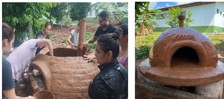
Figuras 8 e 9: Últimas fileiras de tijolos e finalização. Fonte: Elaboradas pelo autor.
