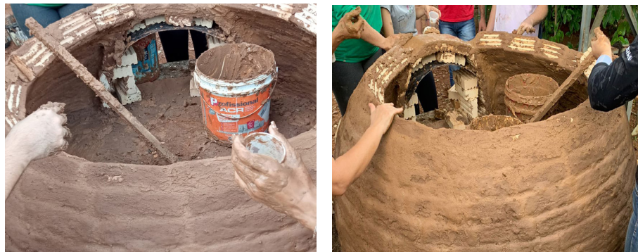
Figuras 6 e 7: Assentamento de tijolos. Fonte: Elaboradas pelo autor.
