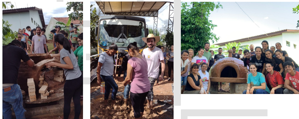
Figuras 10, 11 e 12: Últimas fileiras de tijolos e finalização. Fonte: Elaboradas pelo autor.
