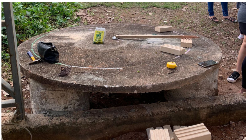
Figura 1: Base para forno de pizza.
