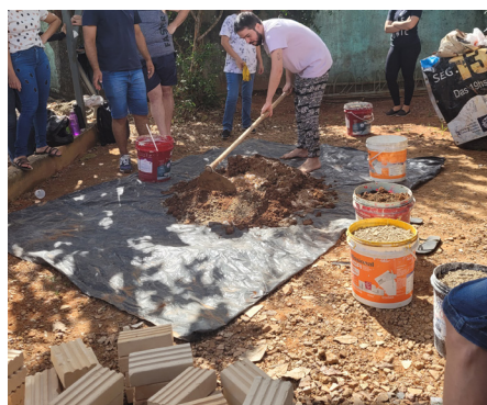
Figuras 2 e 3: Massa para assentamento de tijolos.
