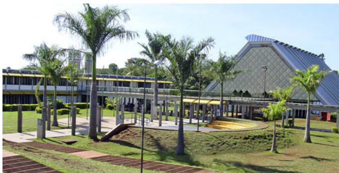
Figura 4 Edifício do Ciac
