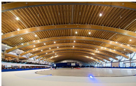
Figura 2 Cobertura em MLC (Vancouver, Canadá)
