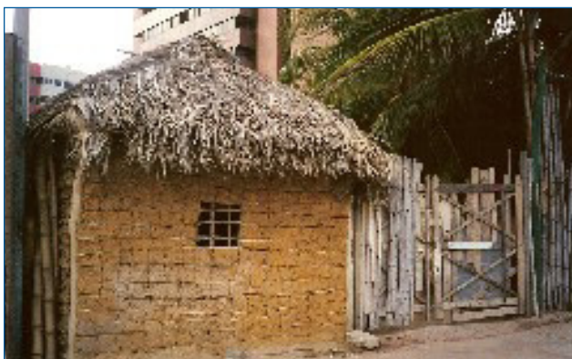
Figura 2 Construção de pau a pique, década de 1990. Rua Professora Hígia Vasconcelos, Ponta Verde, Maceió, AL. Fonte: Acervo dos autores.
