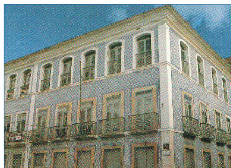
Figura 3 Construção em cantanaria – Sobrado Lagos & Cia., São Luís, MA.
