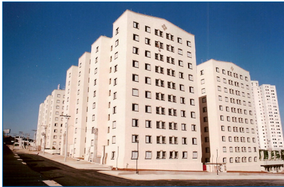
Figura 11 Condomínio Edifício Morada dos Pássaros, conjunto dos prédios concluídos. Avenida do Oratório, São Paulo.
