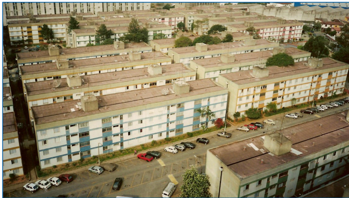
Figura 9 Condomínio Central Parque Lapa. Rua Corcovado, São Paulo.
