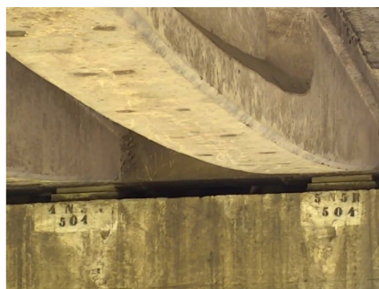
Figura 15 Inspeção dos aparelhos de apoio com auxílio de drone
