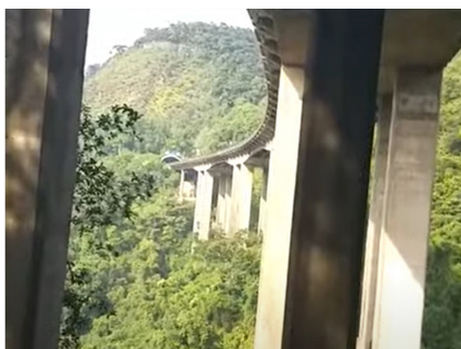
Figura 14 Vista da obra de arte especial
