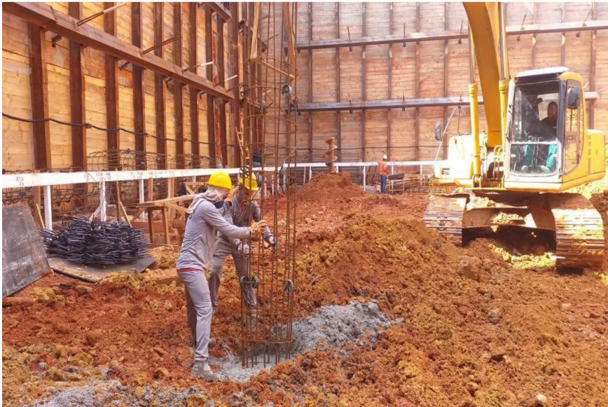
Figura 6 Introdução de armadura da estaca.
