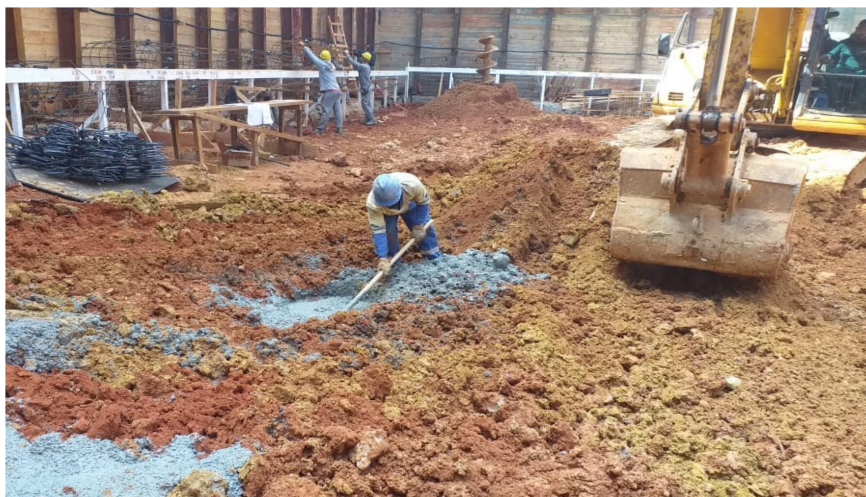
Figura 5 Estaca em obra após retirada da perfuratriz
