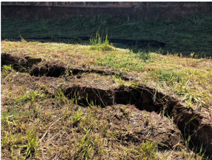
Figura 8 Primeiro escorregamento do solo, próximo ao talude
