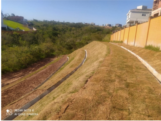
Figura 12 Talude com paramento de geocomposto
