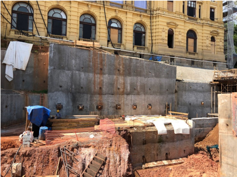
Figura 1 Obra da cortina atirantada no Museu do Ipiranga
