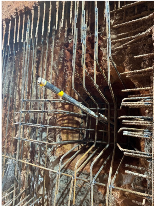
Figura 4 Tirante instalado e parede da cortina não concretada
