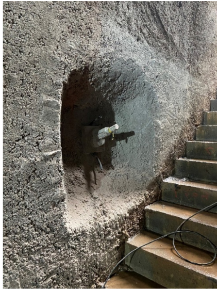
Figura 5 Vista de um tirante recuado, em fase de execução
