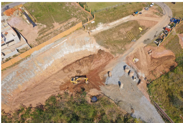
Figura 7 Obra em solo grampeado
