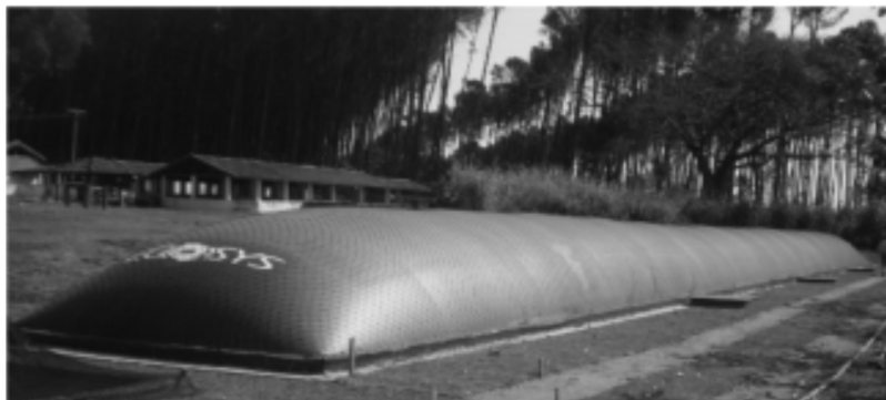
Figura 3 Biodigestor de modelo canadense
