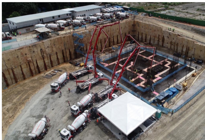
Figura 1 Concretagem da primeira etapa do radier
