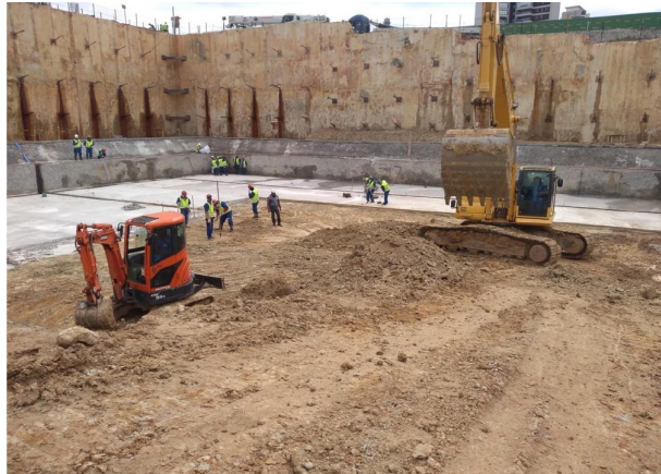
Figura 10 Escavação da base do radier – Torre 4
