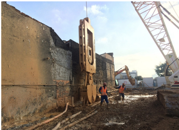
Figura 9 Escavação para execução das lamelas (paredes)
