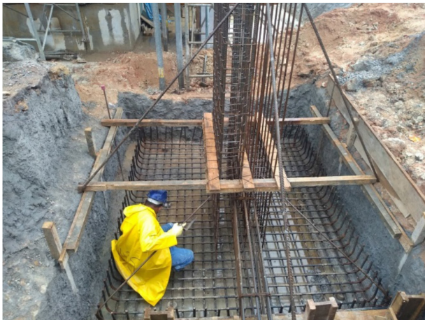
Figura 12 Armação da sapata
