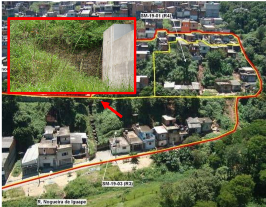
Figura 2 Vista parcial do Jardim Arantes com a aplicação do muro de gabião no setor SM-19-03.
