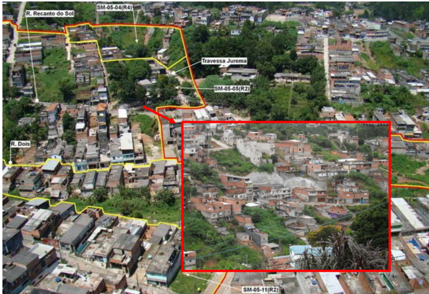
Figura 3 Vista parcial do Jardim Recanto Verde II com a aplicação do solo grampeado no setor SM-05-05.
