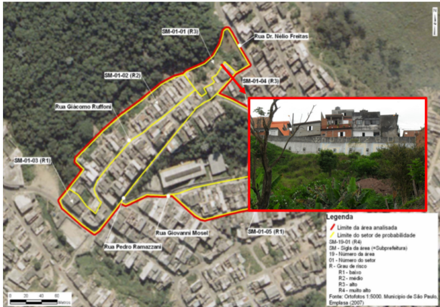
Figura 4 Vista geral do Jardim Recanto Verde I com a aplicação da cortina atirantada no setor SM-01-01.
