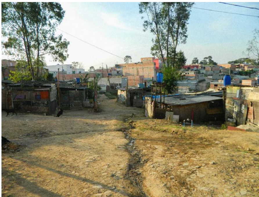
Figura 4: Drenagem nas ruas do Jardim Gaivotas, São Paulo. Águas usadas correm em fendas erodidas a céu aberto. Fonte: João Gabriel de Oliveira (2022).
