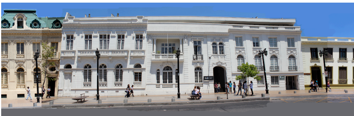
Figura 7 — Foto Edifício Faculdade de Saúde UDP após intervenção.
