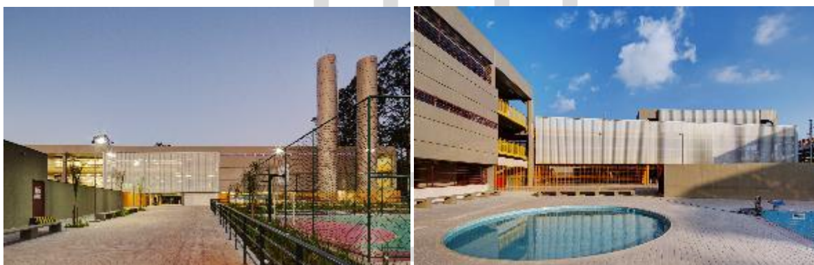
Figura 6 e 7: Vista exterior, esportes – quadra e piscina. Fonte: Pregolato & Kusuki, 2020.
