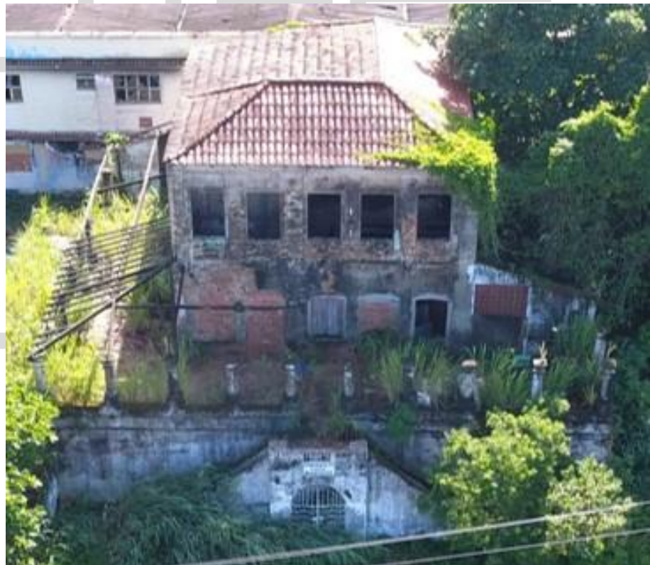
Figura 1: Fachada principal da edificação-sede onde observamos o corpo principal terminando em uma larga varanda, chamada alpendre, com colunas em alvenaria de tijolo muito bem construídas em estilo toscano. Ainda podemos ressaltar sua implantação direta no solo em área elevada e a moldura que os vãos do alpendre realizam em direção à cidade do Rio de Janeiro, sendo possível observarmos o morro do corcovado ao longe. Fonte: Carvalho (2018).
