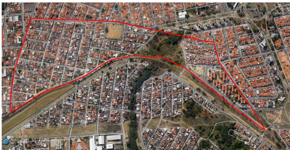
Figura 2: Foto aérea com a demarcação de intervenção da CDHU, no município de Sumaré, na região metropolitana de Campinas, em São Paulo. Trata-se de regularização de área ocupada com 498 lotes (lado esquerdo) e de conjunto habitacional construído para a realocação de famílias da ocupação original com 389 unidades (lado direito), atendimento total de 887 famílias. Fonte: Base de dados da CDHU e Google Maps, 2020.
