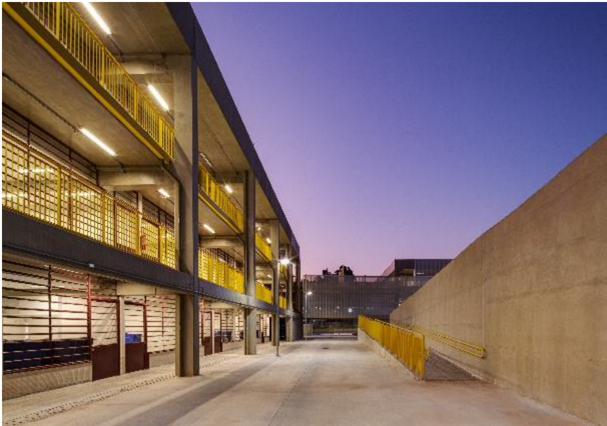
Figura 5: Vista exterior, conexões. Fonte: Pregnoloato & Kusuki, 2020.
