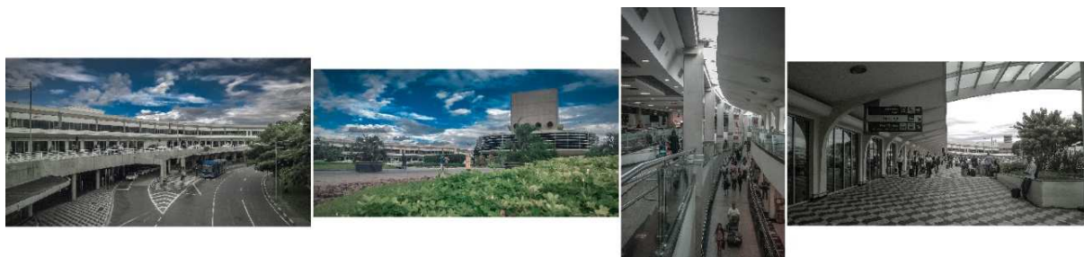
Figuras 5a a 5d (da esquerda para a direita): Vistas do terminal de passageiros após as ampliações: nota-se os contrastes de tempos e perda da referência térrea e da permeabilidade transversal e visual. Fonte: Acervo fotográfico dos autores, 2017.
