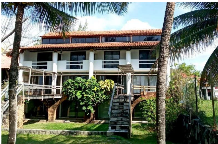
Figura 9: Residencial Enseada dos Corais (1989) por Gilson Miranda e Vera Pires demonstrando a verticalidade expressa pela integração de níveis por meio do uso da coluna sobre arcos de alvenaria. Fonte: Acervo Vera Pires.
