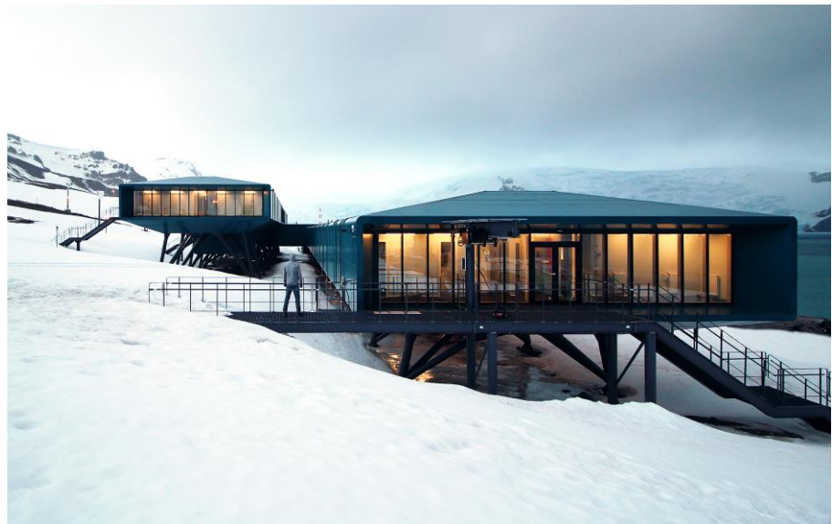
Figura 4: Vista a partir do Sul. Fonte: Eron Costin / Estúdio41.
