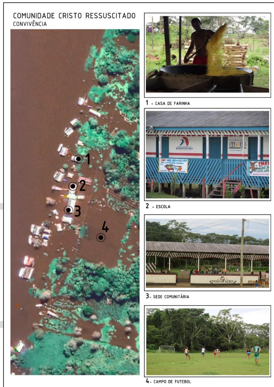
Figura 5: Equipamentos comunitários de convivência da comunidade ribeirinha “Cristo Ressuscitado” – Manacapuru. Fonte: Elaborado pelos autores.
