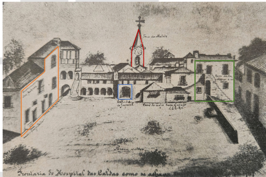
Figura 1: “Frontaria do Hospital das Caldas, como se achava em 28 de março de 1747”. Desenho de d. Luís de Vermell Y Busquets. Destacamos, em laranja, a enfermaria dos pobres; em azul, a entrada do Hospital; em vermelho, a Igreja e em verde, a Casa de Câmara e Cadeia da Vila. Fonte: Adaptado de Ferrari, Ferrari e Correia (1930, p. 41).
