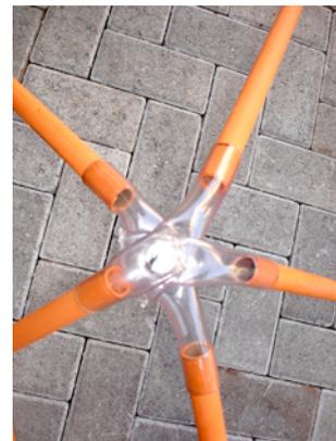
Figuras 9, 10 e 11 - **Terceira Etapa** - detalhes de conexões. Ao se transpor das maquetes para os materiais reais utilizados na construção em escala 1/1, verifica-se que os desenhos das junções, conexões e encaixes implicam no equilíbrio da estrutura. Agora há o peso específico de cada material (o que não acontece na maquete): percebe-se que a “alma” da estrutura reside no projeto dessas conexões. São as qualidades dessas ligações que possibilitam a existência da estrutura.
