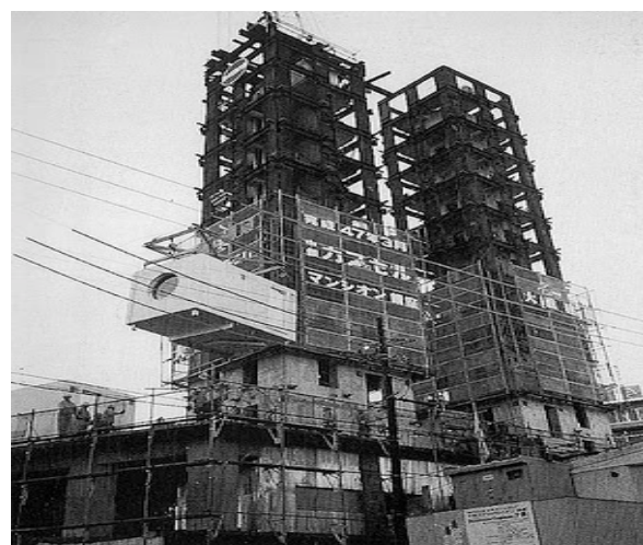
Figura 9 - Montagem da Torre Cápsula.
