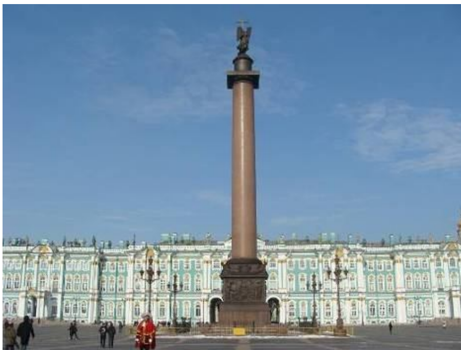
Figura 5: Coluna de Montferrand na praça, e ao fundo, fachada principal do Palácio de Inverno — Hermitage em São Petersburgo — tom verde das superfícies lisas em contraste ao branco e dourado dos estuques. Fonte: Alexandre Mascarenhas, 2009.
