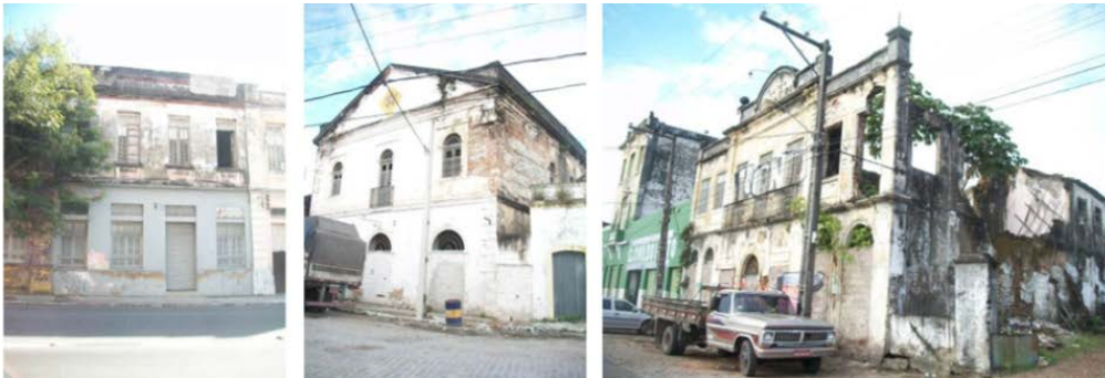
Figura 8: Exemplos de edificações não utilizadas. Fonte: Acervo pessoal.
