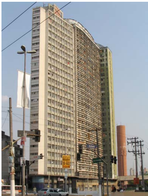
Fig. 4: Edifício São Vito. Foto de José Eduardo Borba Pereira, 2005.
