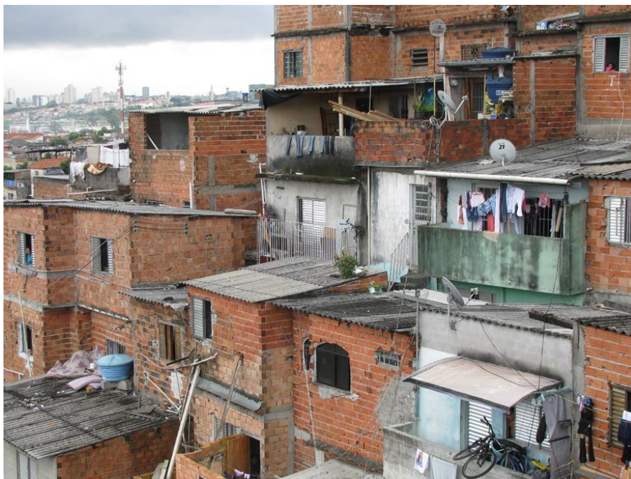
Figura 1: Ocupação irregular da região da Penha, em São Paulo, sujeita a deslizamentos de encosta.
