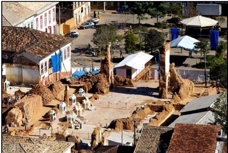
Figura 6: Remanescentes da Igreja Matriz de São Luiz de Tolosa após obras de salvamento executadas pelo Iphan-SP em parceria com a empresa Biapó Fonte: Pereira (2012).
