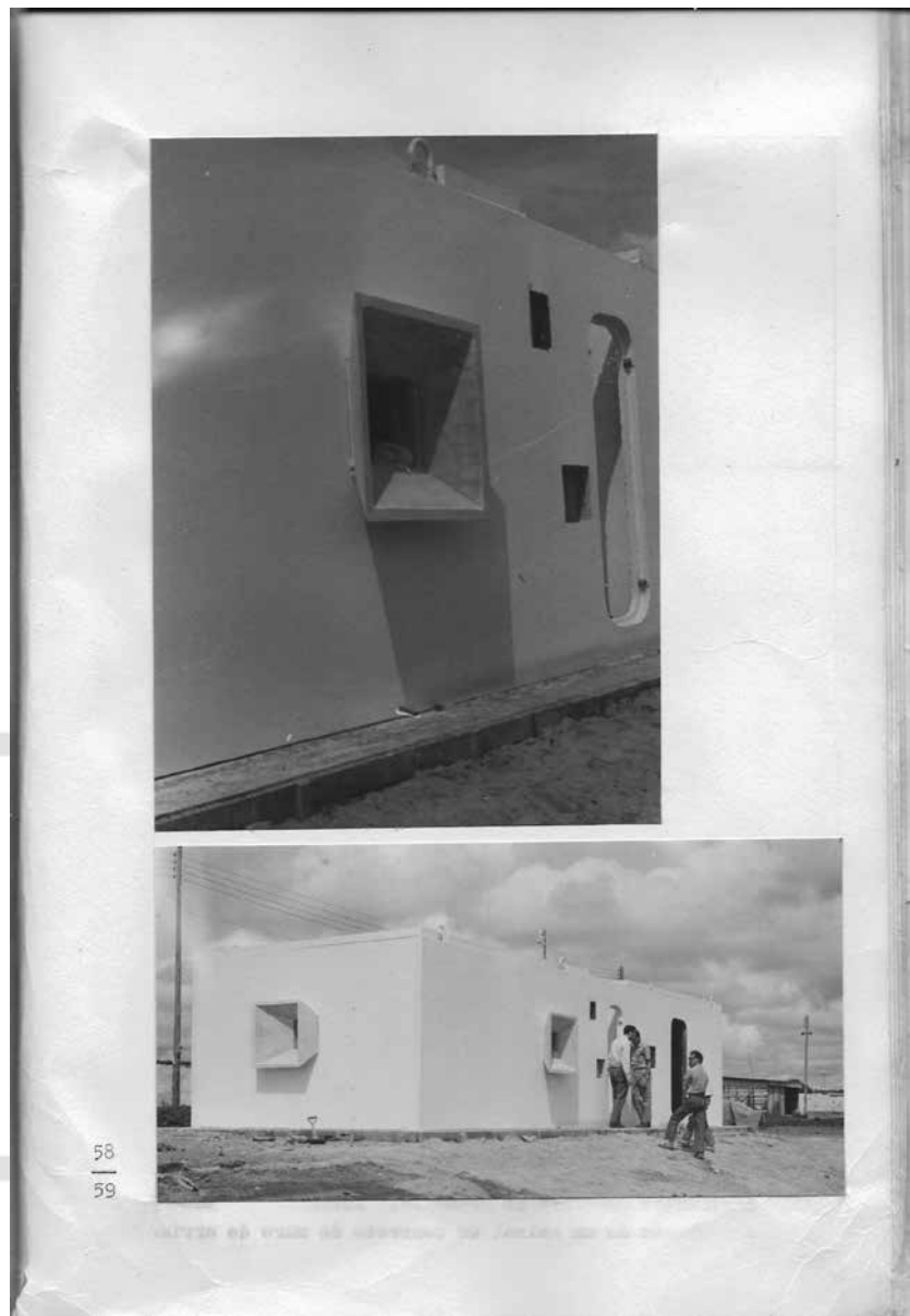
Figura 11: Construção do Protótipo Residencial. Fonte: Pessina (1964).
