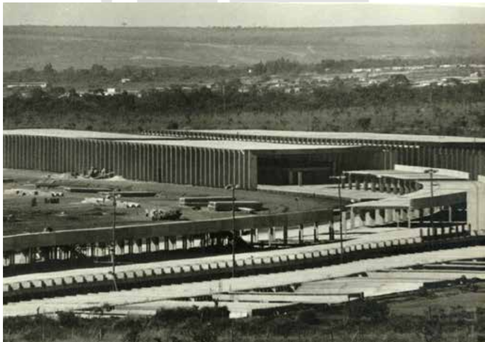
Figura 7: ICC em construção. Fonte: Janveja (1966).
