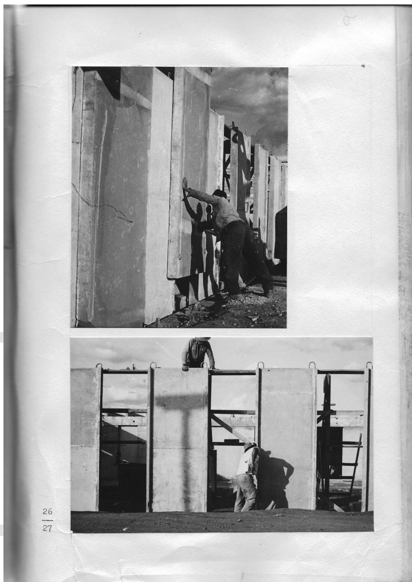
Figura 10: Construção SG. Fonte: Pessina (1964).
