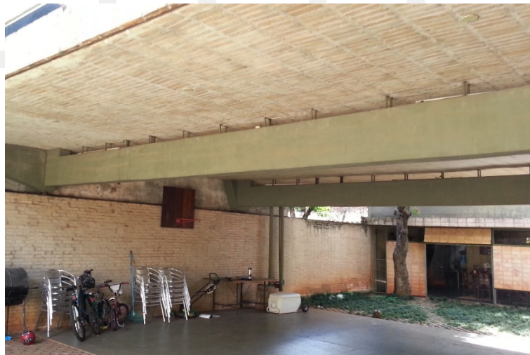
Figura 4: Casa Fanego, viga Vierendeel e laje. Fonte: acervo do autor, fev. 2014.
