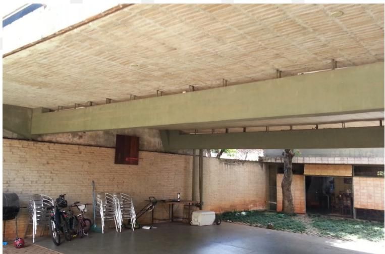
Figura 4: Casa Fanego, viga Vierendeel e laje.
