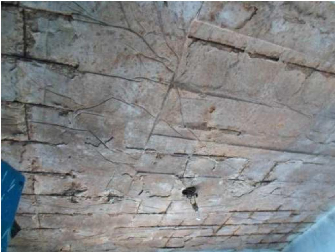
Figura 4. Laje existente com trincas, armaduras descobertas e em processo de corrosão. Fonte: imagem do autor
